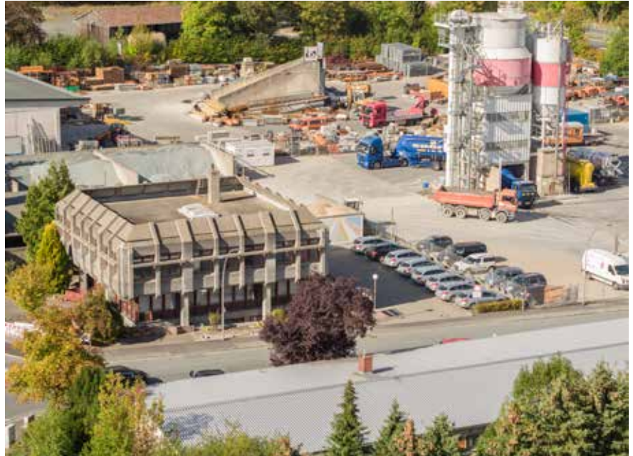
Abbildung 1: Bestandsgebäude Büro- und Verwaltungsgebäudes AS-Bau GmbH (Hof, Bayern)
