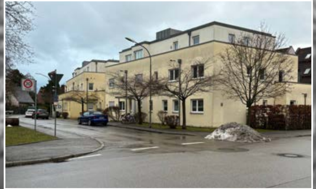
Hermann-Stockmann-Straße, Dachau Architekt: Unbekannt
