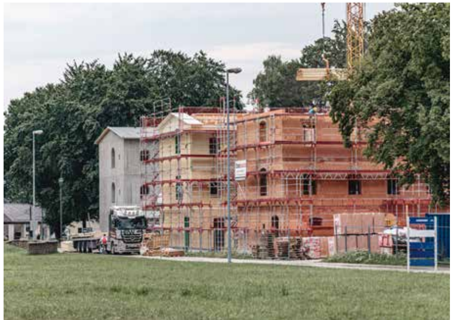
Abbildung 1: Die Forschungshäuser im Bau, Foto: Max Kratzer
