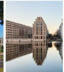
Bürosanierung am Spreerfer (Berlin Kreuzberg) →
