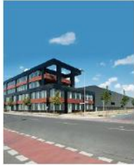
Solar-Produktionsfabrik Berlin Adlershof →
